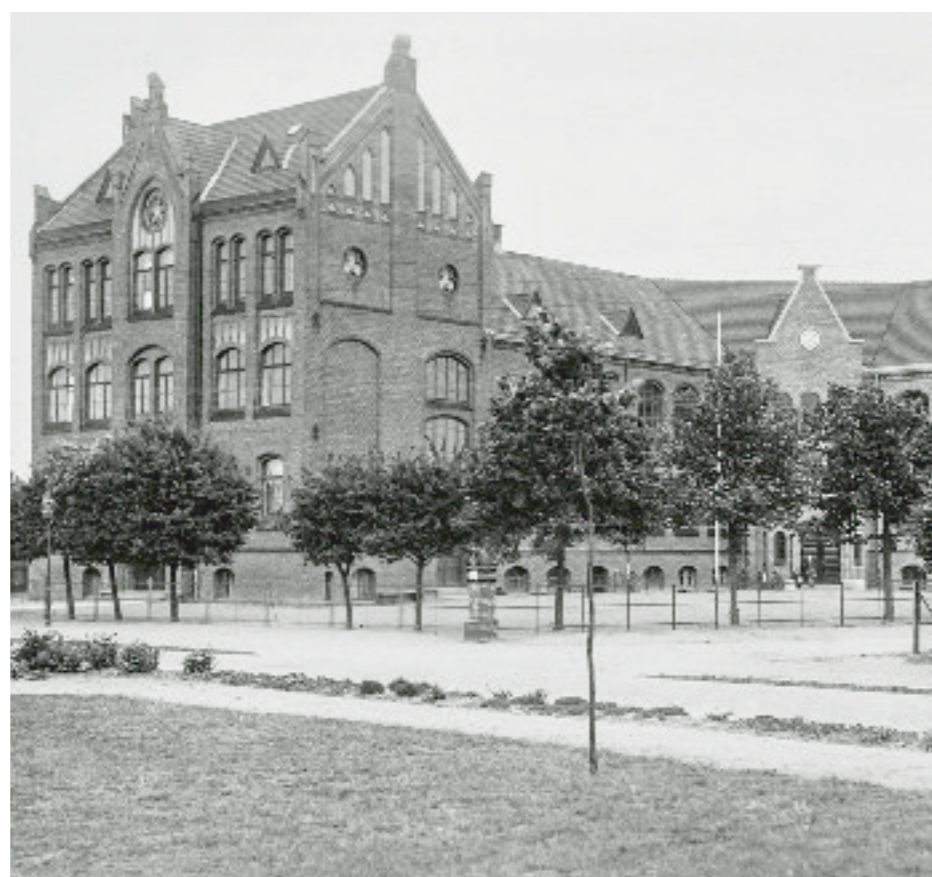
Friedrich-Rohr-Schule 1908 als Knabenbürgerschule gegründet. Friedrich Rohr – ein wohlhabender Ackerbürger der Stadt – richtete eine wohltätige Stiftung ein, da seine Ehe kinderlos blieb. Aus den Erträgen konnte die Schule errichtet werden. Im Krieg als Lazarett genutzt, stand das Gebäude nach 1945 wieder für Schulzwecke zur Verfügung. Heute ist hier die Realschule „Friedrich-Rohr“ – Schule ohne Rassismus – untergebracht.
