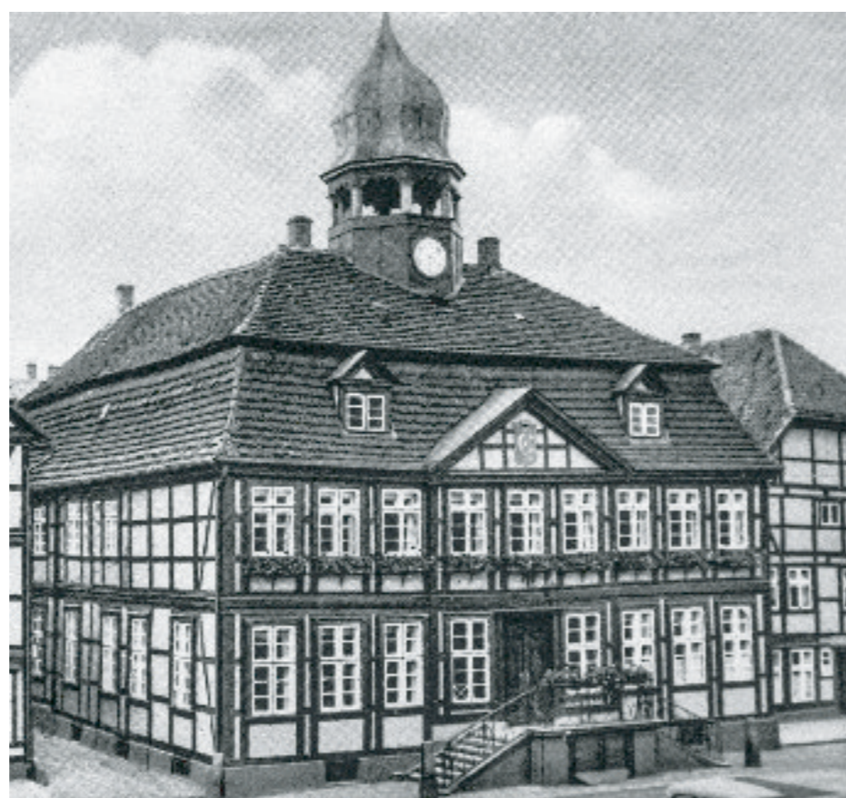
Rathaus In seiner Form nach dem Wiederaufbau von 1725/26. Sitz der Bürgermeister und Verwaltung der Stadt. Bürgermeister Dr. Walter Bötcher 1931 – 1945, war Kriegsveteran, Mitglied der Deutschen Volkspartei und Jurist. Er war seit 8/1933 Mitglied der SA und trat 1937 in die NSDAP ein, war mehrfach an der Front und geriet im Mai 1945 in brit. Gefangenschaft. Als Bürgermeister 1945 in Grabow abgesetzt, wurde er ab 1946 Kammerei-Senator in Lüneburg. Eine Straße ist dort nach ihm benannt.
