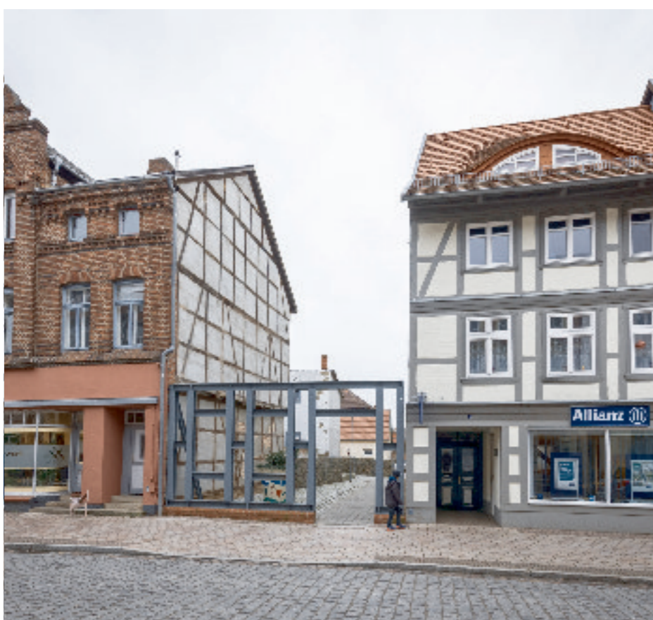
Marktstr.5/6 heute Wegen Baufälligkeit wurde das Haus Nr. 5 abgerissen, in Nr.6 befanden sich nach dem Krieg verschiedene Geschäfte.
